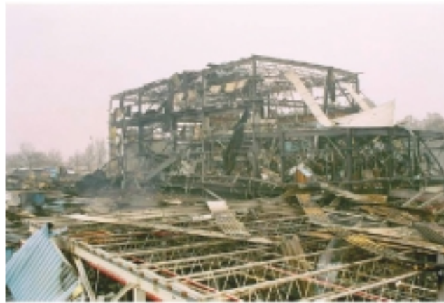
Produktionsbau in der Prozessindustrie nach einer Staubexplosion Usine de procédés industriels après une explosion de poussières
