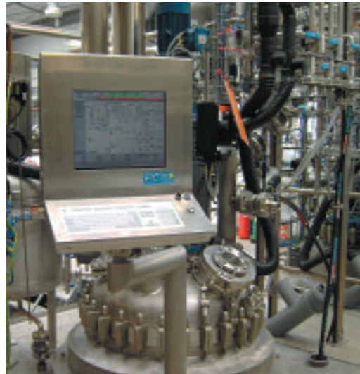
Abb. 3: PC100-Bildschirmarbeitsplatz mit kombinatorischem Explosionsschutz Fig. 3: Station de travail PC100 avec protection antidéflagrante combinée
