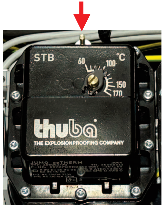
Abbildung 37 Sicherheitstemperaturbegrenzer
