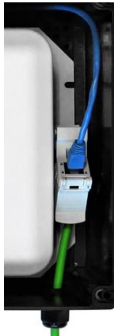
Batch-Kabel (Verbindung Anschlussmodul zum Access Point)
