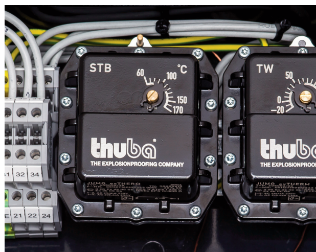
Temperaturüberwachungssystem mit Temperaturregler und Sicherheitstemperaturbegrenzer Typ TMS
