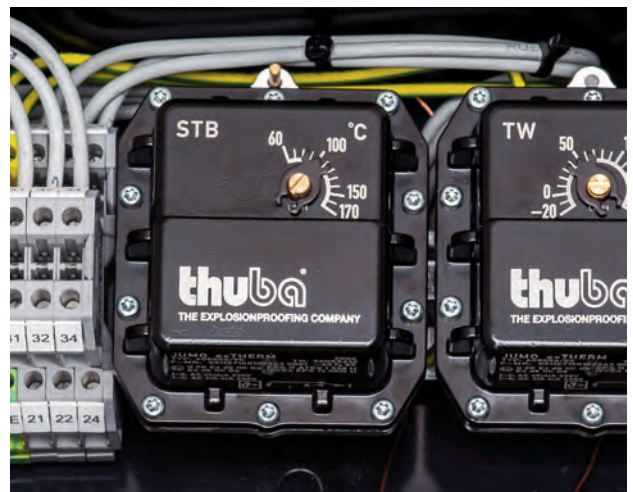
Temperaturüberwachungssystem mit Temperaturregler und Sicherheitstemperaturbegrenzer Typ TMS
